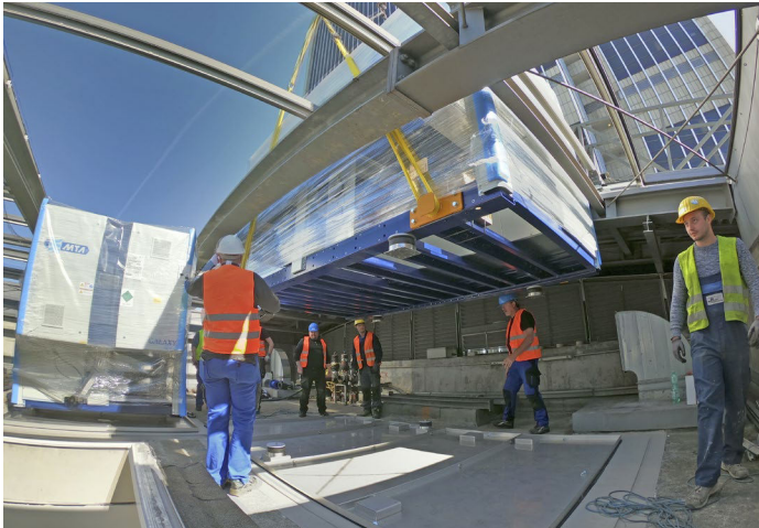
Beim Einbringen der Kältemaschinen ins Dach des Bürohauses zählte jeder Zentimeter.
