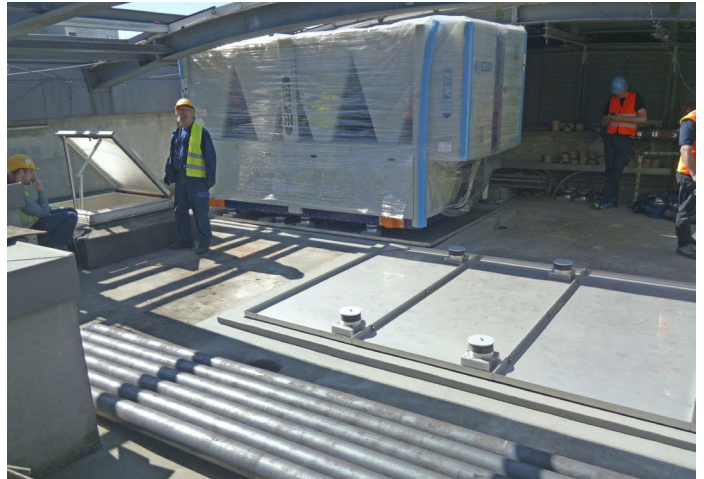
Bodenausgleich, Glykolprotektor und Schwingungsdämpfer „warten“ auf den zweiten Kaltwassersatz.
