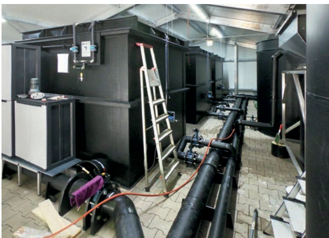
Riesige Biofilter für bis zu 80.000 Liter pro Stunde
