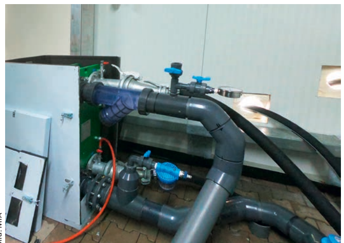
Plattenwärmetauscher zur Systemreinigung
