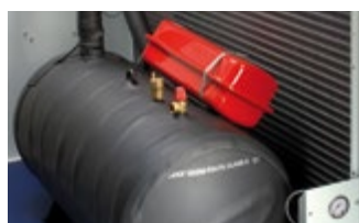
Integriertes Pumpenmodul mit oder ohne Speichertank.
